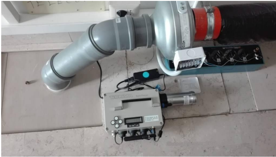
Ventilazione forzata del vespaio
